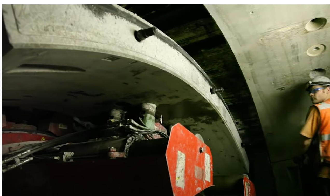
Mise en place du voussoir
